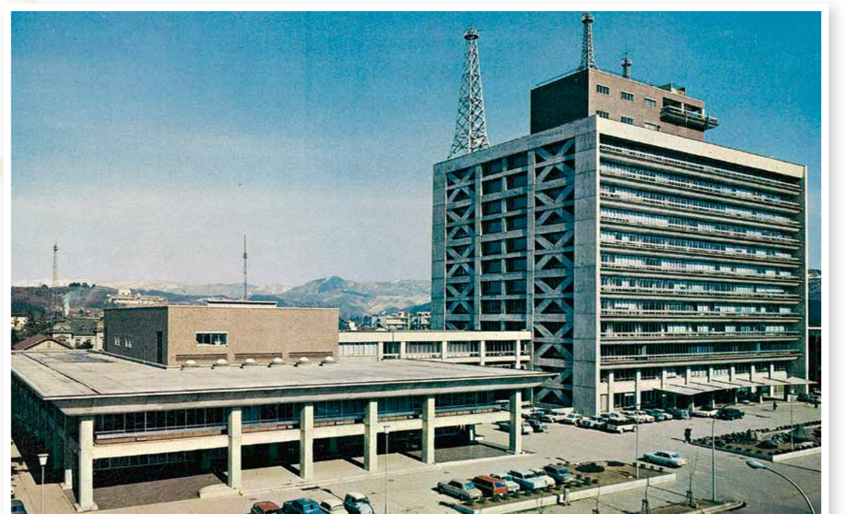
昭和40年に完成した岩手県庁舎・岩手県議会議事堂
