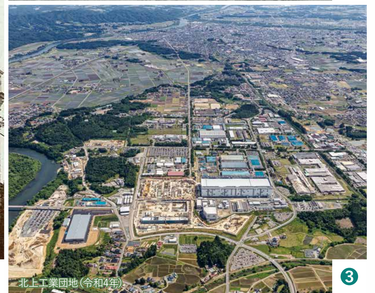
北上工業団地(令和4年)
