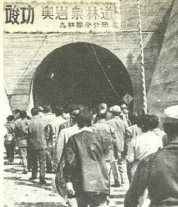
森林開発の大動脈として奥岩泉林道が完成。
