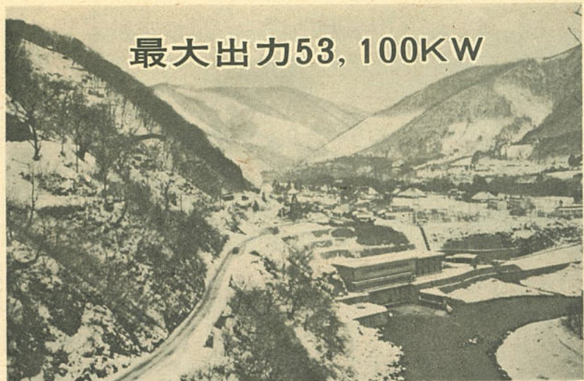
「仙人発電所は北上川の支流、和賀川の流域にあり、岩盤まで掘削して築造された鉄筋コンクリート造りの建物で、大きさは三五m×二〇mです」
