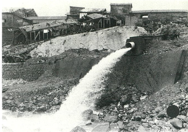
▼松尾鉱山跡から湧き出る強酸性の鉱毒水。この鉱毒水をほぼ完全に処理する新中和処理施設の建設が始まった。
