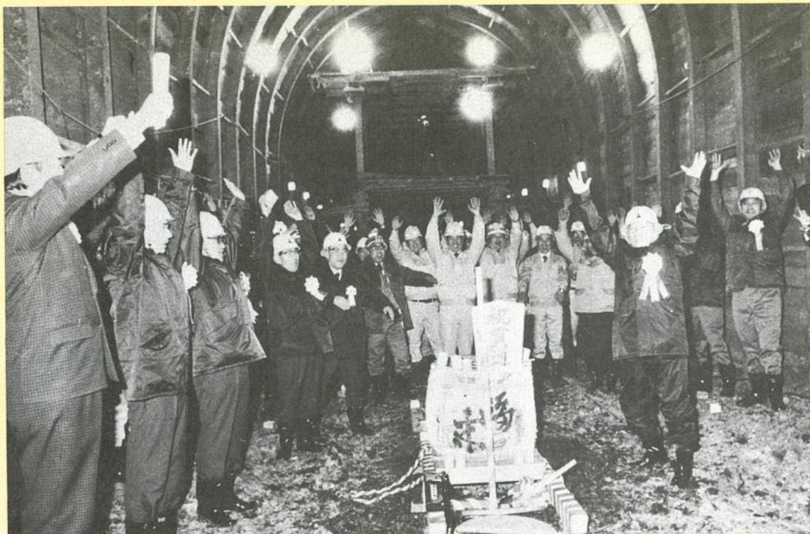
▲久慈線最後のトンネル工事、切牛トンネルが1月26日貫通。三陸縦貫鉄道はトンネルが多いのが特徴。久慈線久慈-宮古間71.1キロメートルには43カ所39キロメートル(55%)のトンネルがあり、この貫通で工事がヤマを越した。
