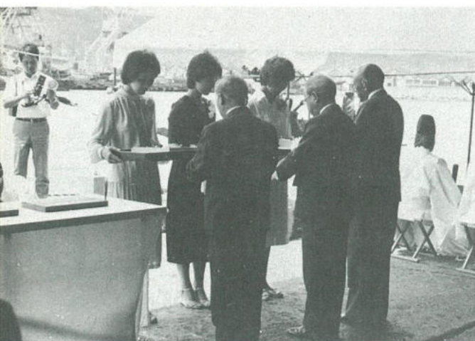
▲世紀の大事業「釜石港湾口防波堤」の建設が始まった。
