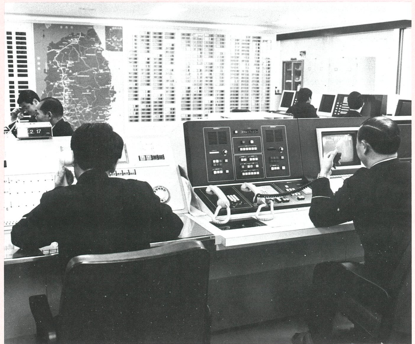
▲新しい装置が入り、機能が大幅に向上した通信指令室
