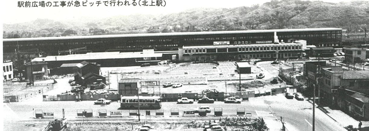
駅前広場の工事が急ピッチで行われる(北上駅)
