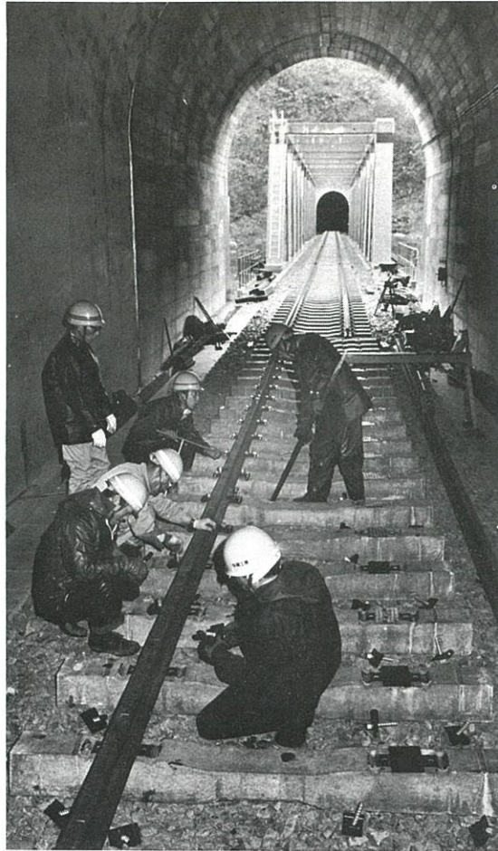
▼三陸鉄道の完通を目指して着々と進められるレールの敷設作業(3月)
