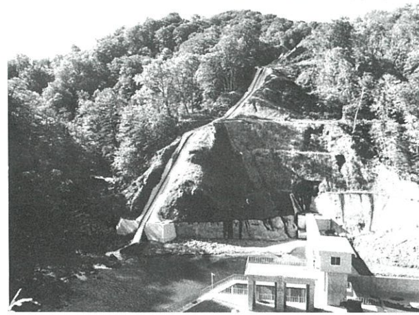
県営初の水路式、北ノ又発電所の本取水口(10月)
