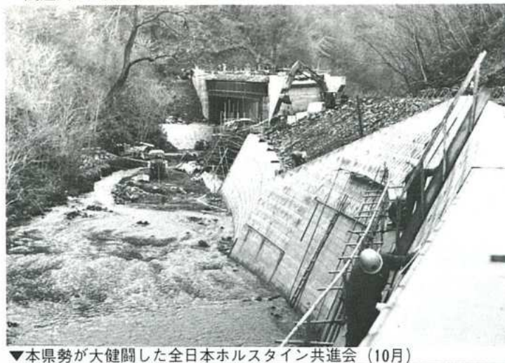
▼高速関連道路整備も着々と進む。（県道戸呂町一軽米線）（11月）
