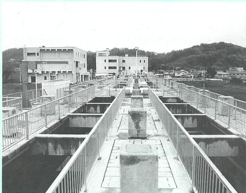
第一期部分が完成した一関浄化センター
