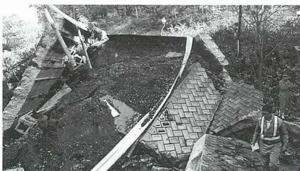
道路などの被害状況の調査
