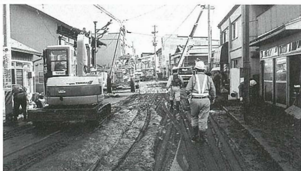
堆積した泥の除去作業
