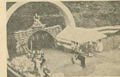
仙岩峠に大トンネル掘削が始まり、 冬も日本海岸への道が通れる日は近 い。
