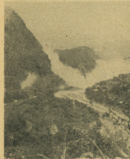
【昭和二十五年十月二十五日、ダムに使用する石を得るため五十六トンの爆薬をつかった日本一の犬發破】
