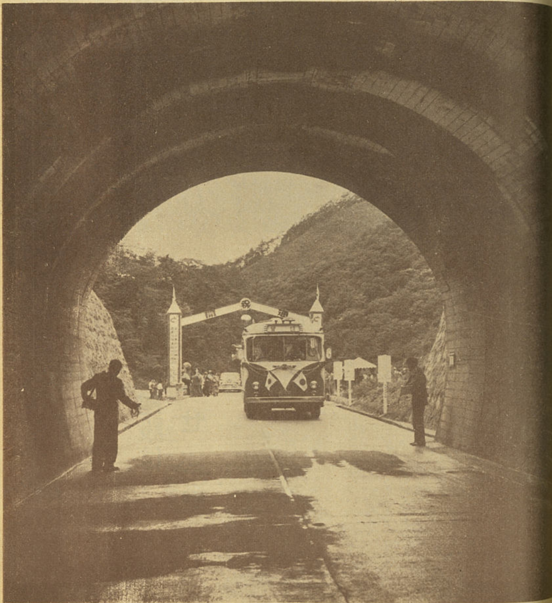
県民待望の仙人トンネル道路が完成し、9月12日その開通式が行われた。
