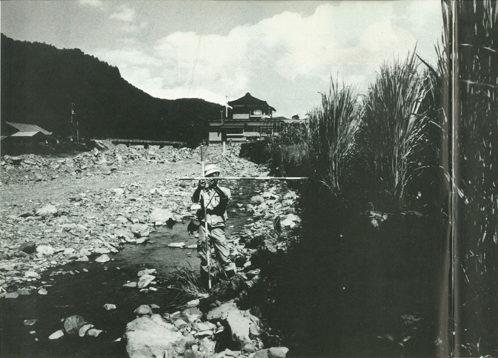
▲被災後、一日も早い復旧作業に取り掛かるため 現地調査を行う土木事務所職員（遠野市青笹）
