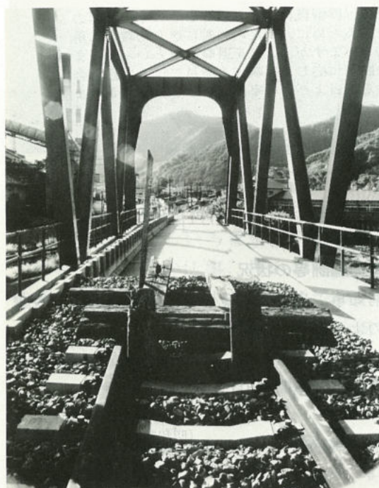
▲ 工事再開の見通しが立った盛線（釜石駅付近）
