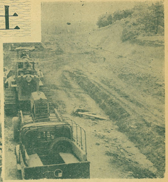
△ (写真) 上は奥中山の国道切替工事で、二十九年から着工三十一年には完成する、実市員六・五米延長三、一八七米、工費六千万円 (写真) 左は長坂、前沢線の長坂橋、架換工事、総工費一億九千万円、長さ四八八米、市員六米
