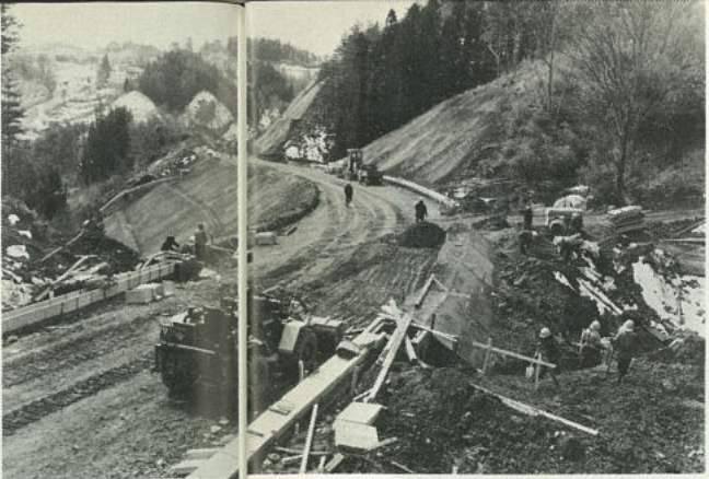
順調に進む建設工事。工事概要は、延長1.7キロ、幅員7メートルの二車線道路（52年8月1日オープン予定）。
