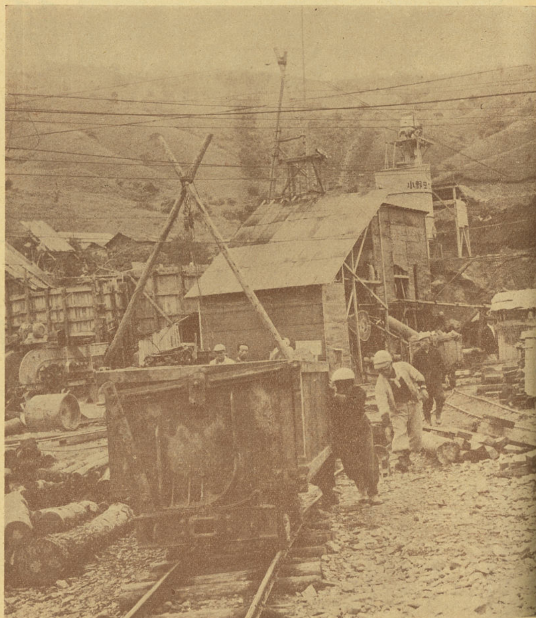
県営岩洞第一発電所の建設現場
