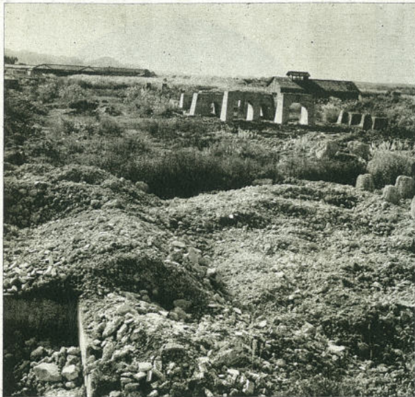
黒沢尻附近の工場敷地予定地(元工場跡)
